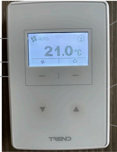
Température de réglage par défaut. Réglage entre 18°C et 25°C.
